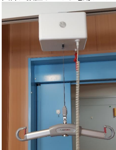
リフターを使用している状況 ※最大200kgまで対応が可能です
